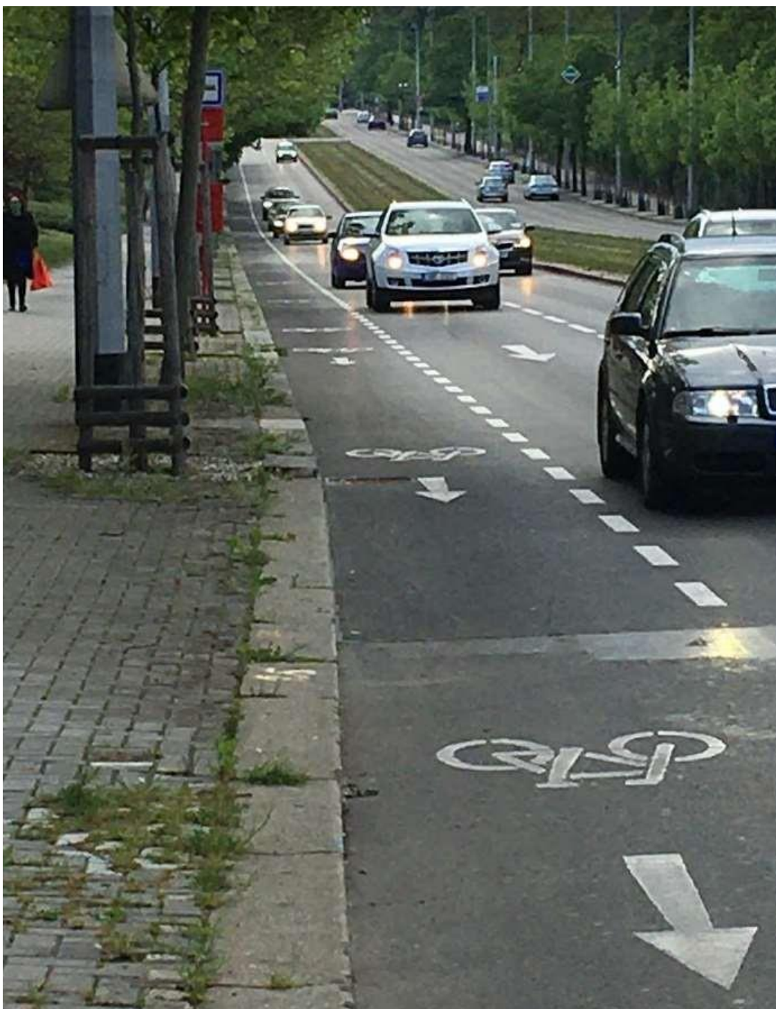
Ilustrační snímek foto z Prahy 6 s ochrannými cyklopruhy na Evropské třídě (silnice I. třídy č. 7). Patrné je zejména respektování prostoru pro cyklisty i přesto, že se v něm zrovna žádný cyklista nepohybuje
