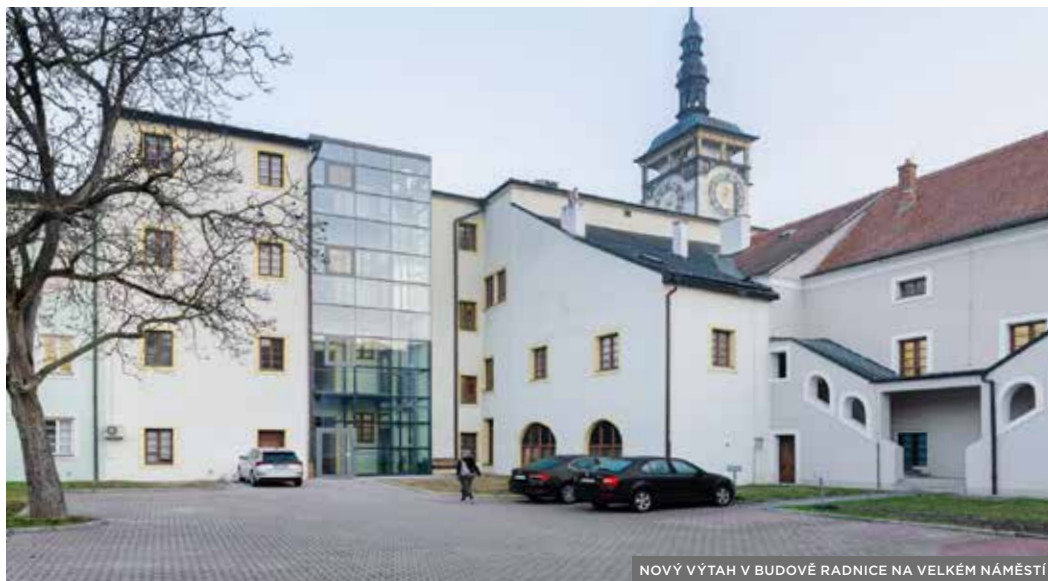
NOVÝ VÝTAH V BUDOVĚ RADNICE NA VELKÉM NÁMĚSTÍ
