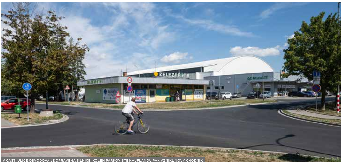
V ČÁSTI ULICE OBVODOVÁ JE OPRAVENÁ SILNICE, KOLEM PARKOVIŠTĚ KAUF LANDU PAK VZNIKL NOVÝ CHODNÍK
