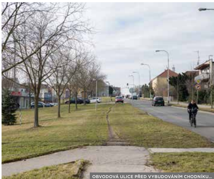
OBVODOVÁ ULICE PŘED VYBUDOVÁNÍM CHODNÍKU...
