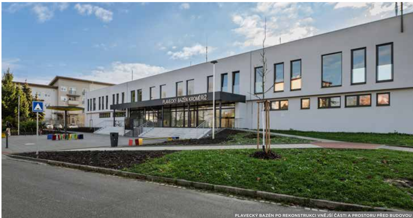
PLAVECKÝ BAZÉN PO REKONSTRUKCI VNĚJŠÍ ČÁSTI A PROSTORU PŘED BUDOVOU
