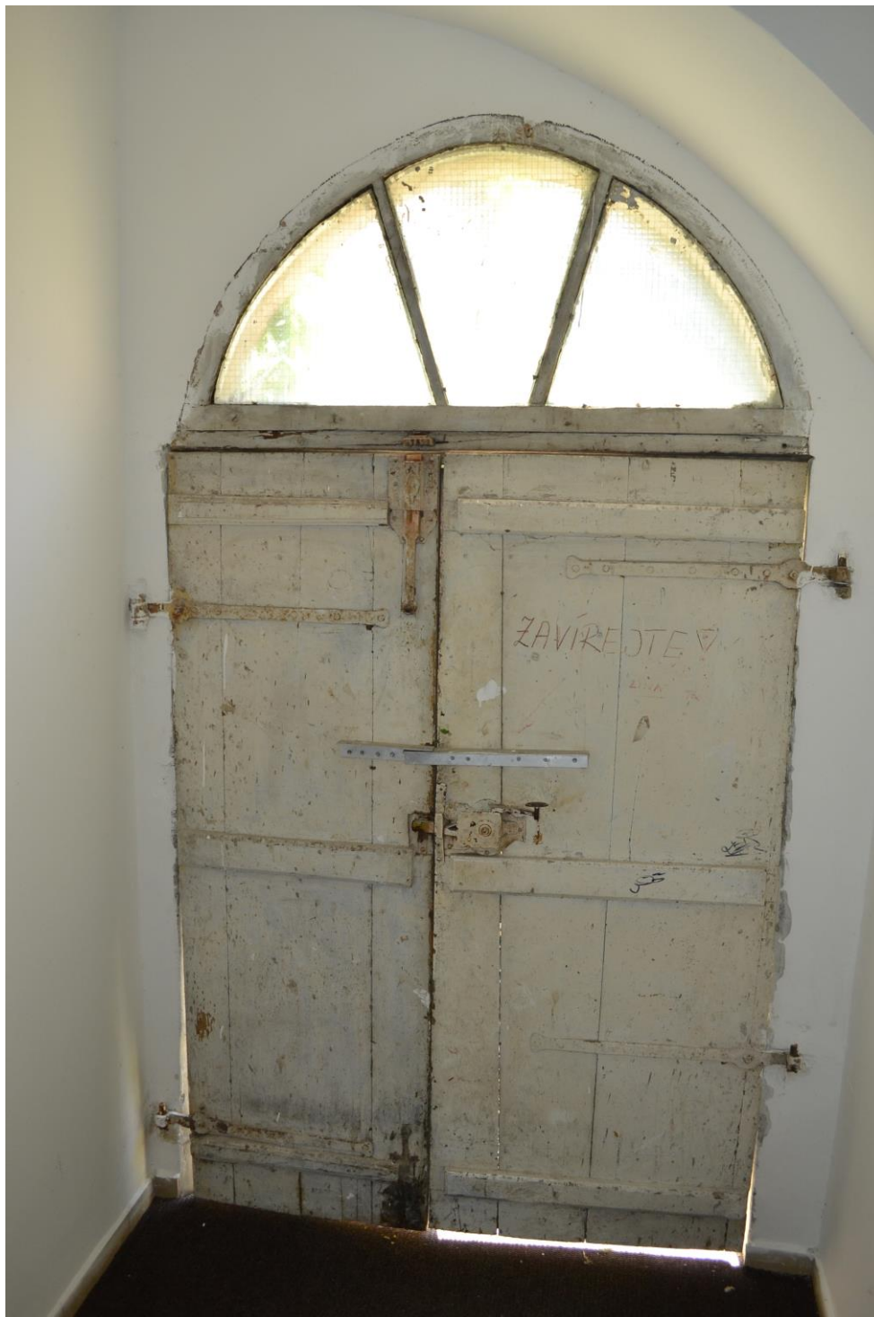
Celkový pohled na konstrukci vstupních dveří s nadsvětlikovým oknem do dvorního traktu z vnitřní strany objektu - interiér
