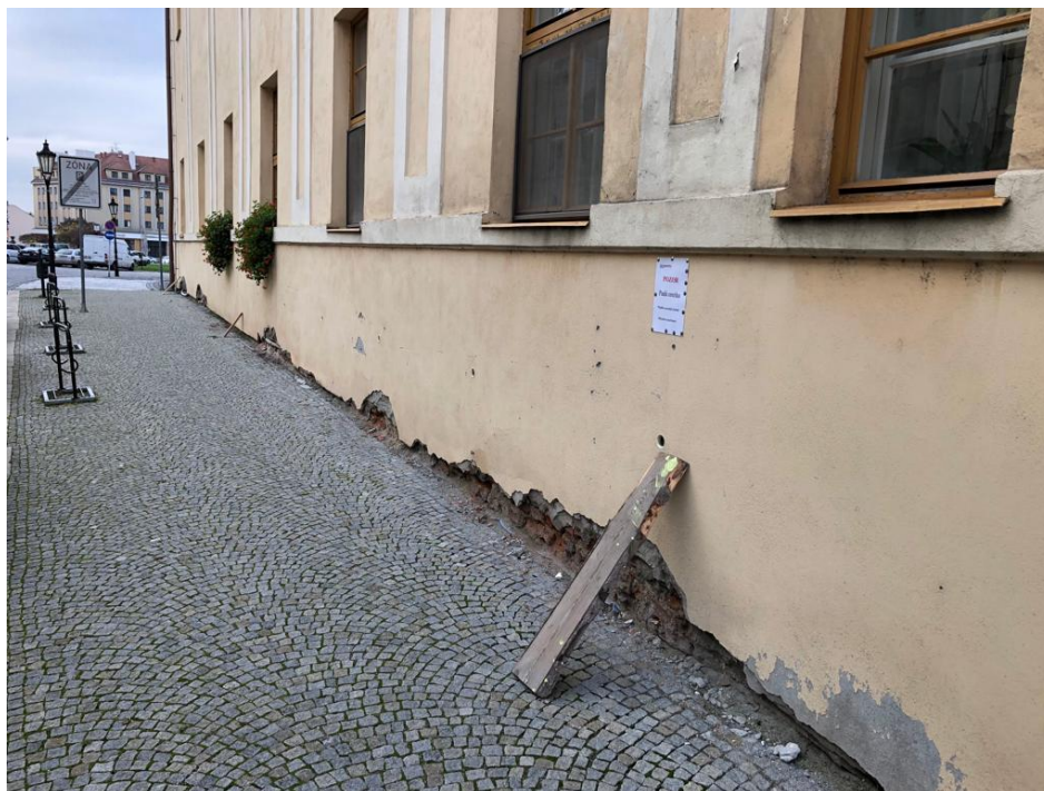
Pohled na fasádu z ulice Jánská
