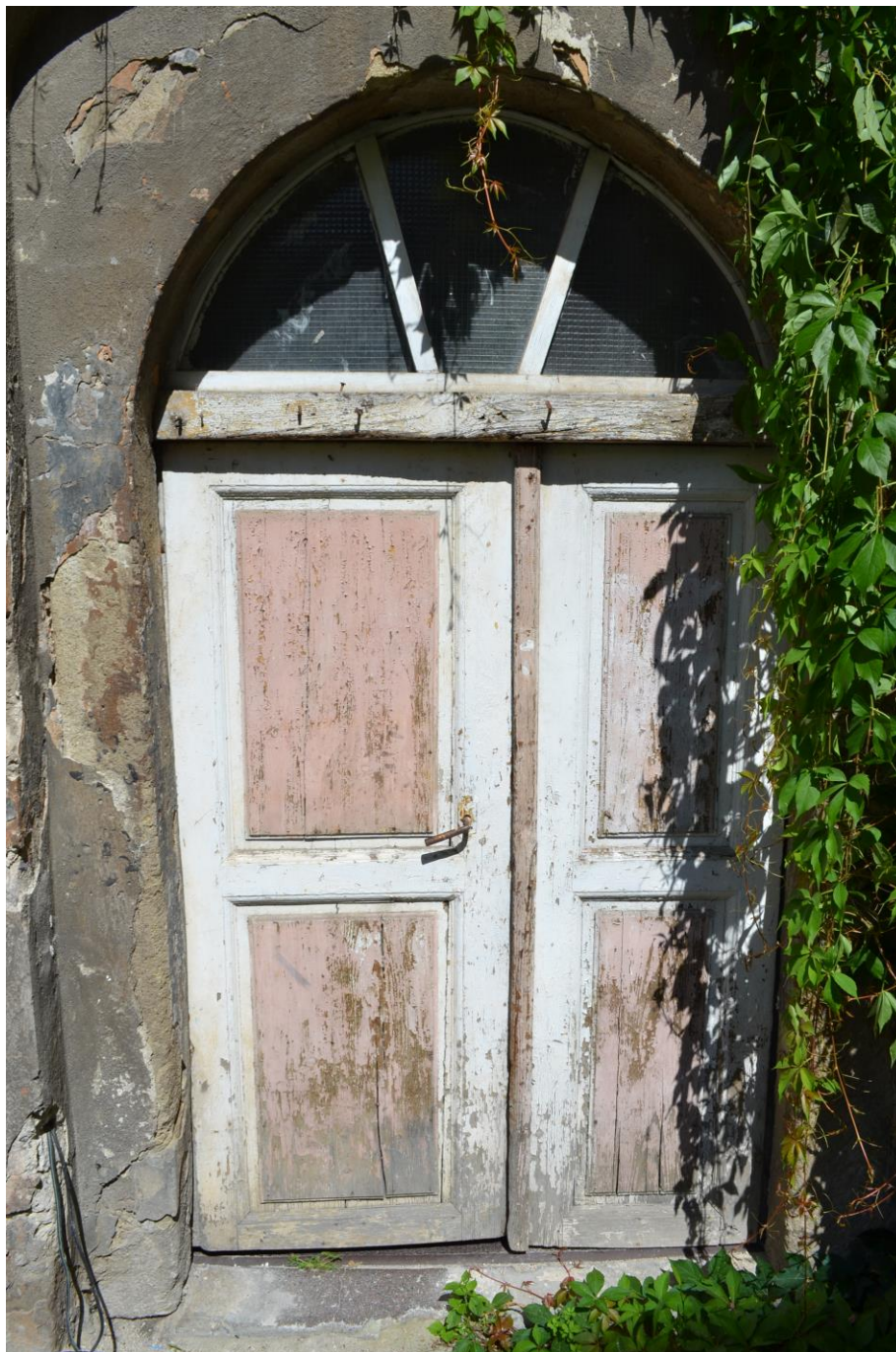
Celkový pohled na konstrukci vstupních dveří s nadsvětíkovým oknem do dvorního traktu z vnitřní strany objektu - exteriér
