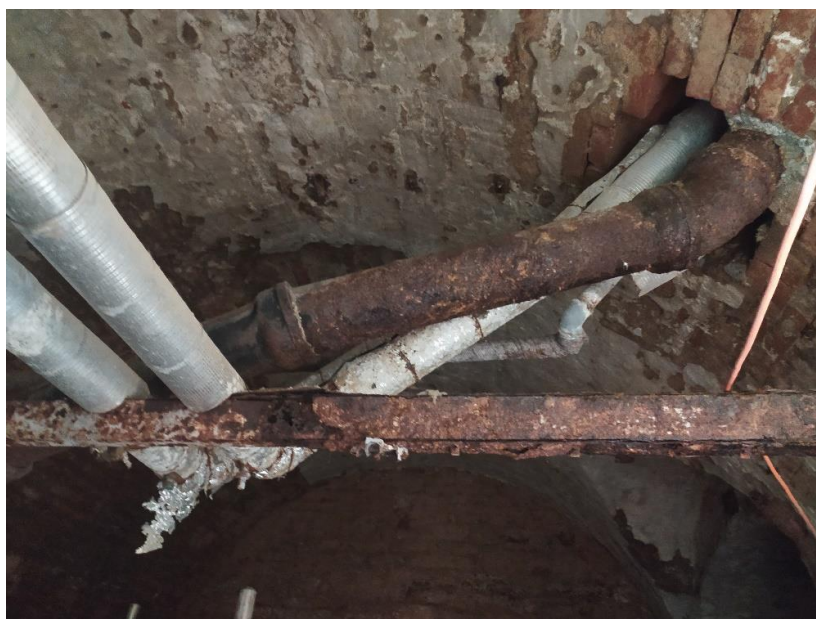
Stav stávajících sklepních prostor
