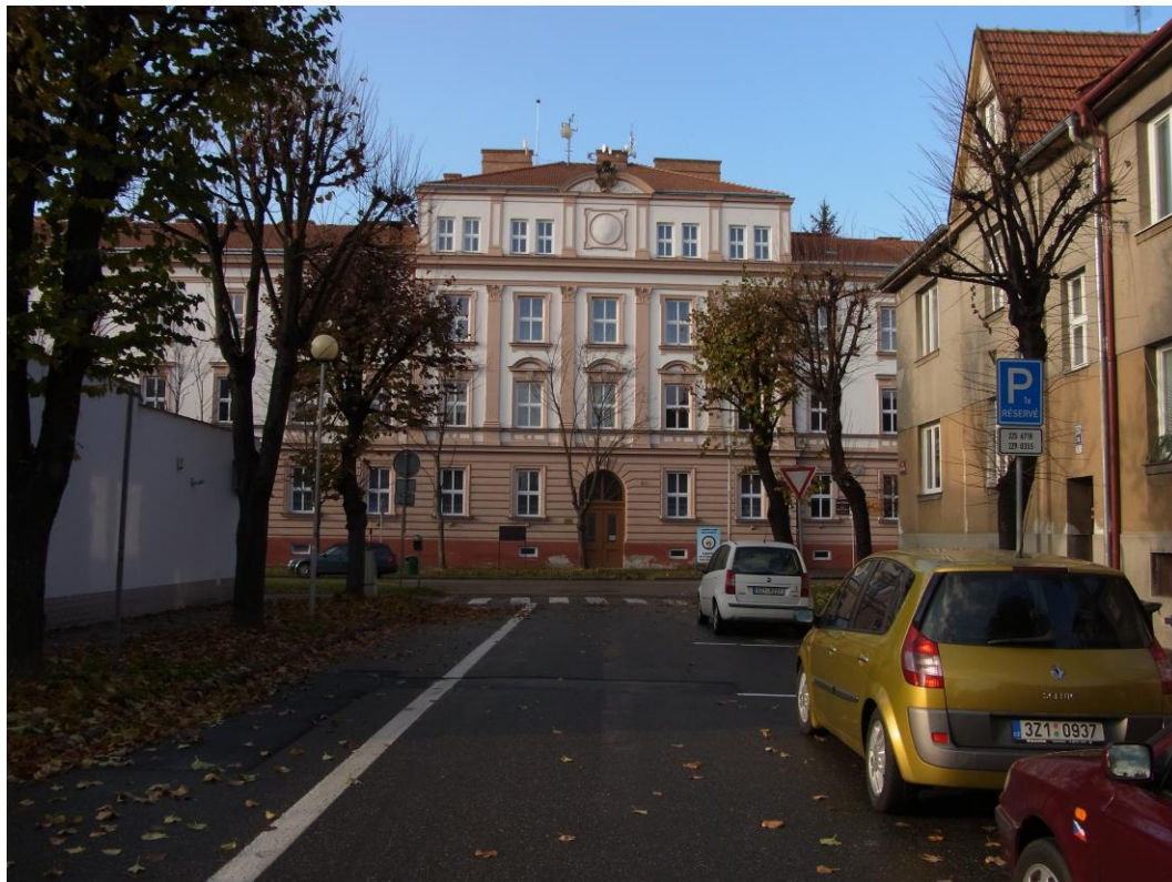
Obr. 14: Budova č.p. 476, pohled na dvorní fasádu, 2015, archiv NPÚ UOP v Kroměříži
