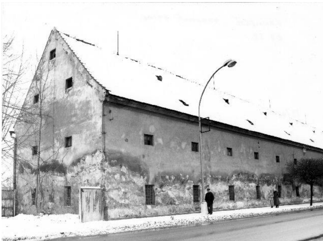
Obr. 09: budova vojenského skladu polovina 18. století, foto nedatováno, archiv NPÚ UOP v Kroměříži.
