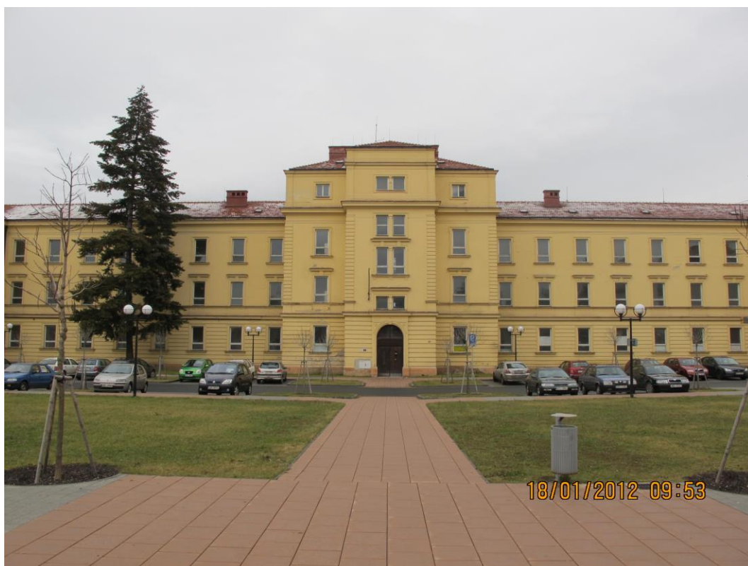
Obr. 13: Budova č.p. 476, pohled na uliční průčelí archiv NPÚ UOP v Kroměříži
