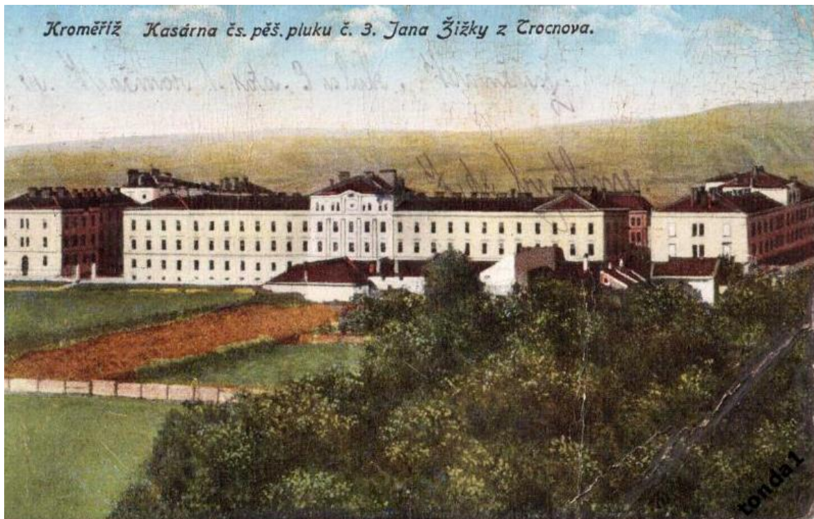
Obr. 15: Historická pohlednice areálu, nedatováno
