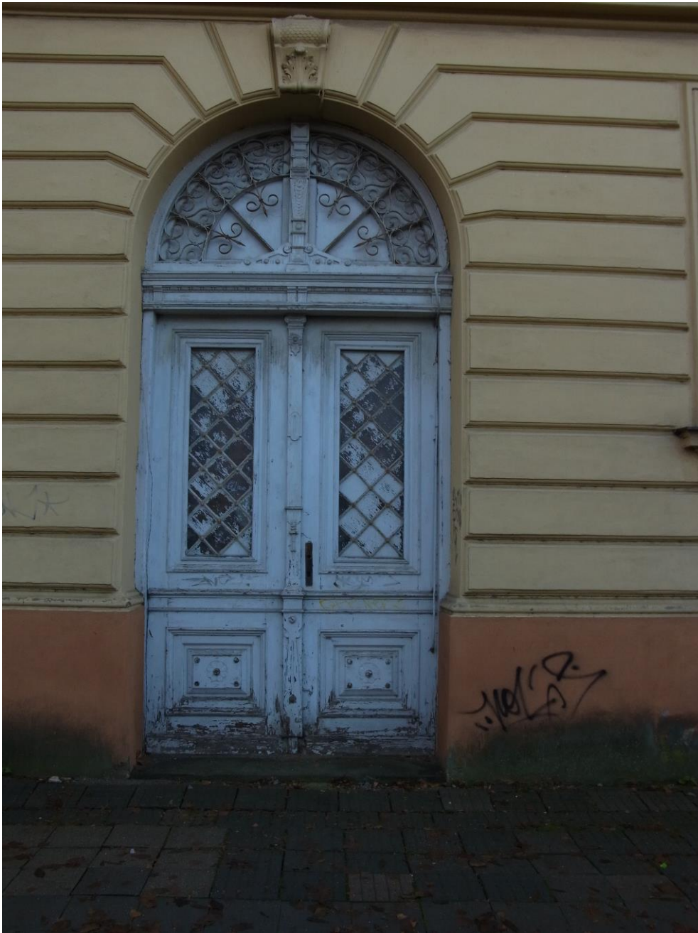
Obr. 18: Budova č.p. 476, původní vstupní dveře, 2015, archiv NPÚ UOP v Kroměříži
