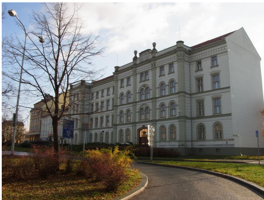
Obr.10: Budova č.p. 517, bývalá kasárna, , foto 10.2015, archiv NPÚ UOP v Kroměříži.
