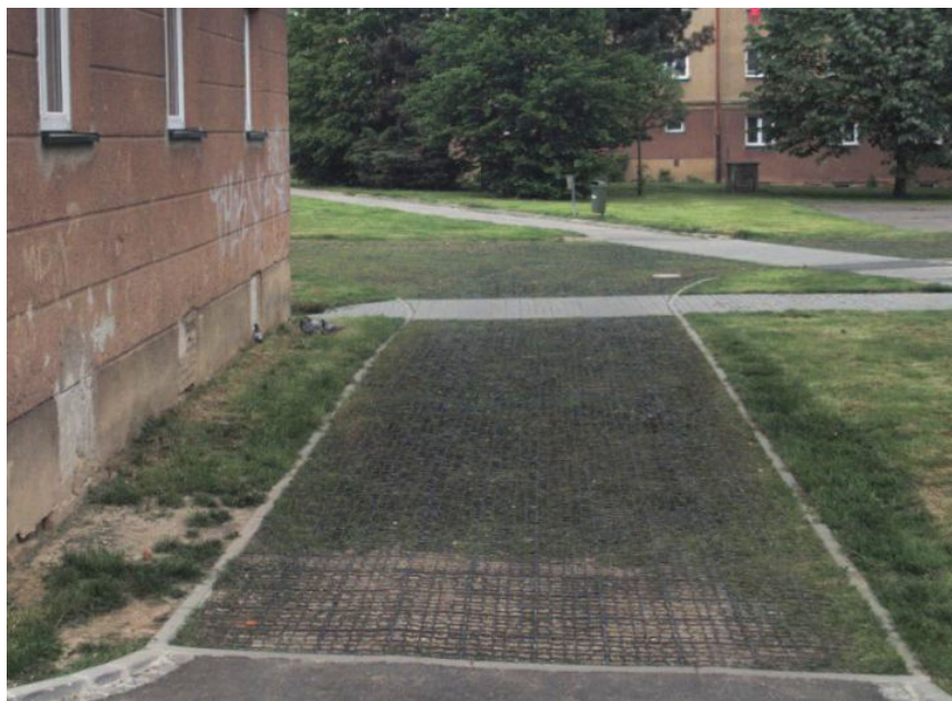
Obrázek 3 Příklad řešení parkování plastovými zatravněvacími rohožemi
