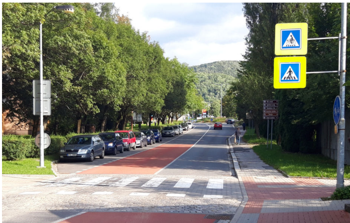
Obrázek 10 Vhodná úprava cyklopřechodu a přechodu pro chodce na zvýšeném prahu s dopravním značením na výložnicích
