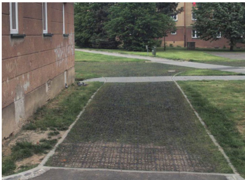
Obrázek 3 Příklad řešení parkování plastovými zatravněvacími rohožemi
