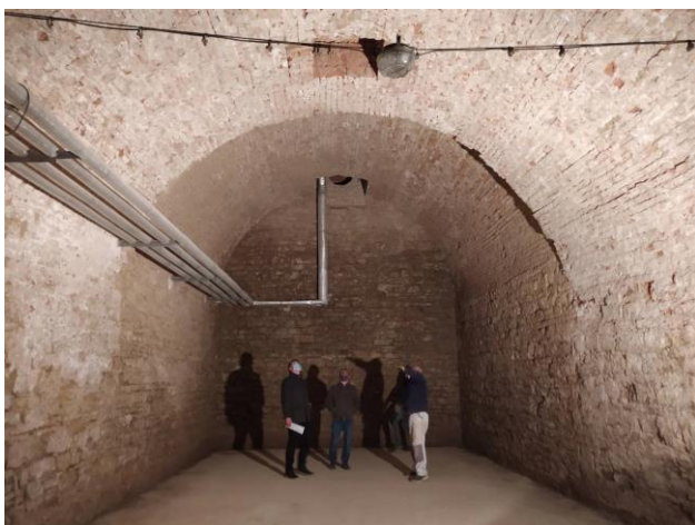
sklepní prostory po provedení sanačních prací - po otlučení omítek v roce 2020
