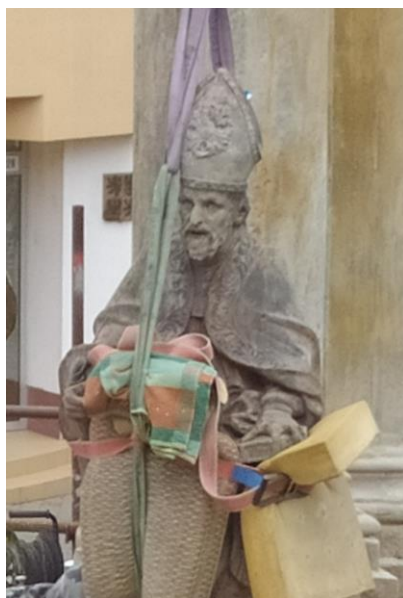
zpětná montáž sochařské výzdoby střední části sloupu
