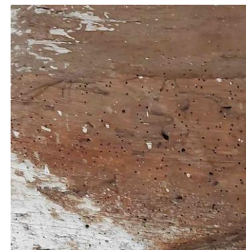
napadení červotočem
