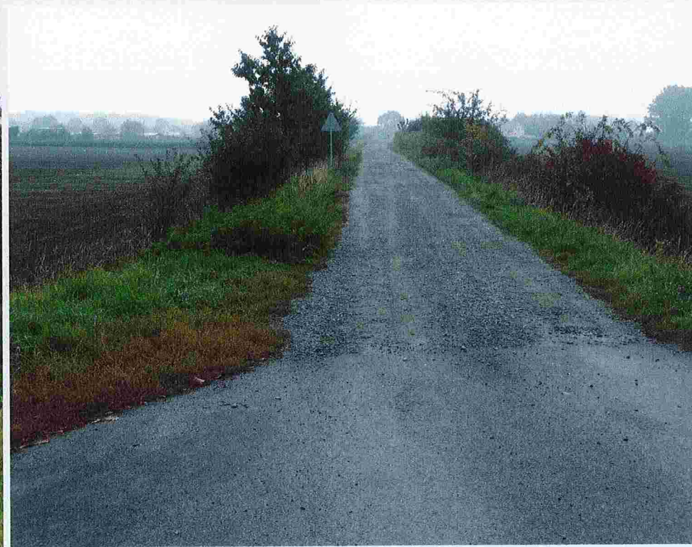
Pohled od železničního přejezdu směrem na východ
