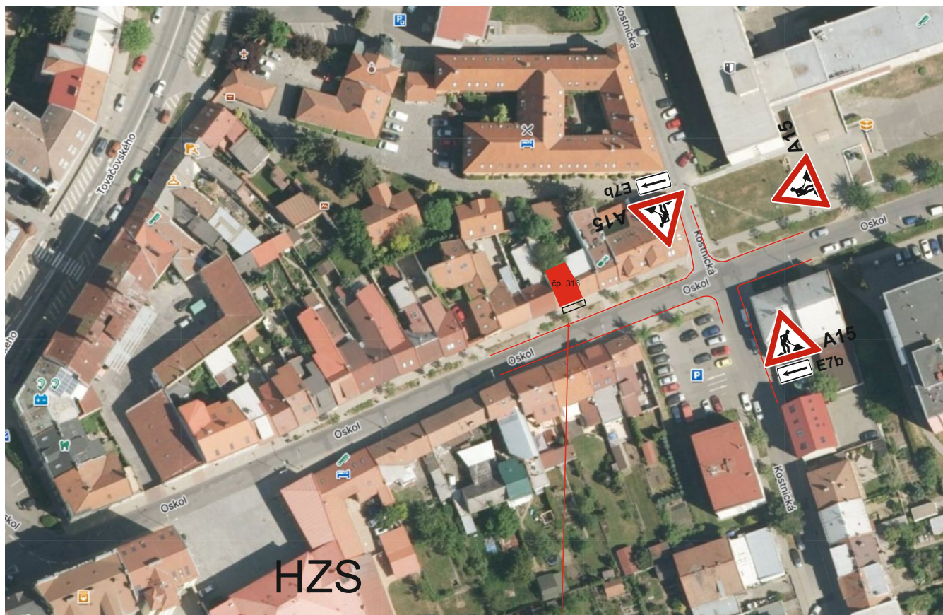
Pracovní místo v úseku mimo křižovatky
