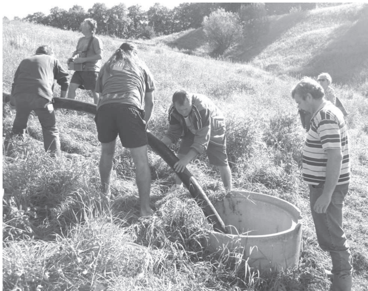
Pomocí mechanického ramena bylo nutné dostat hadici s betonovou směsí od domíchávače až k jínce u paty skládky. Foto: P. Zrna
