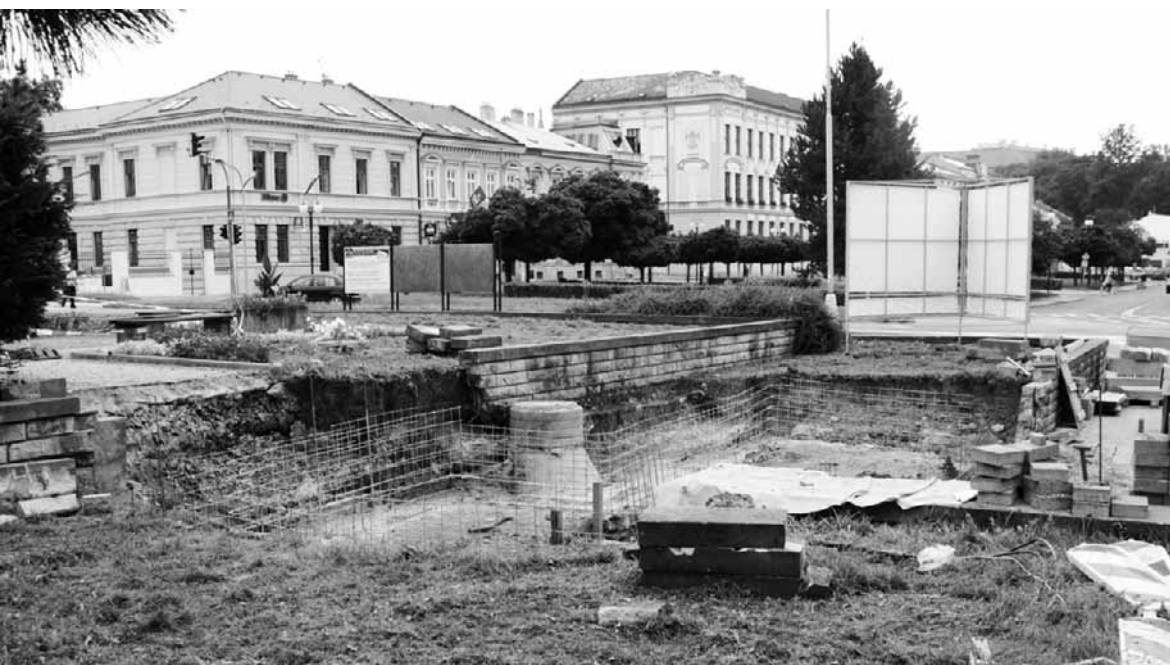
Vybagrovaná jáma se zaplní kamením a zakryje železobetonovou deskou.
