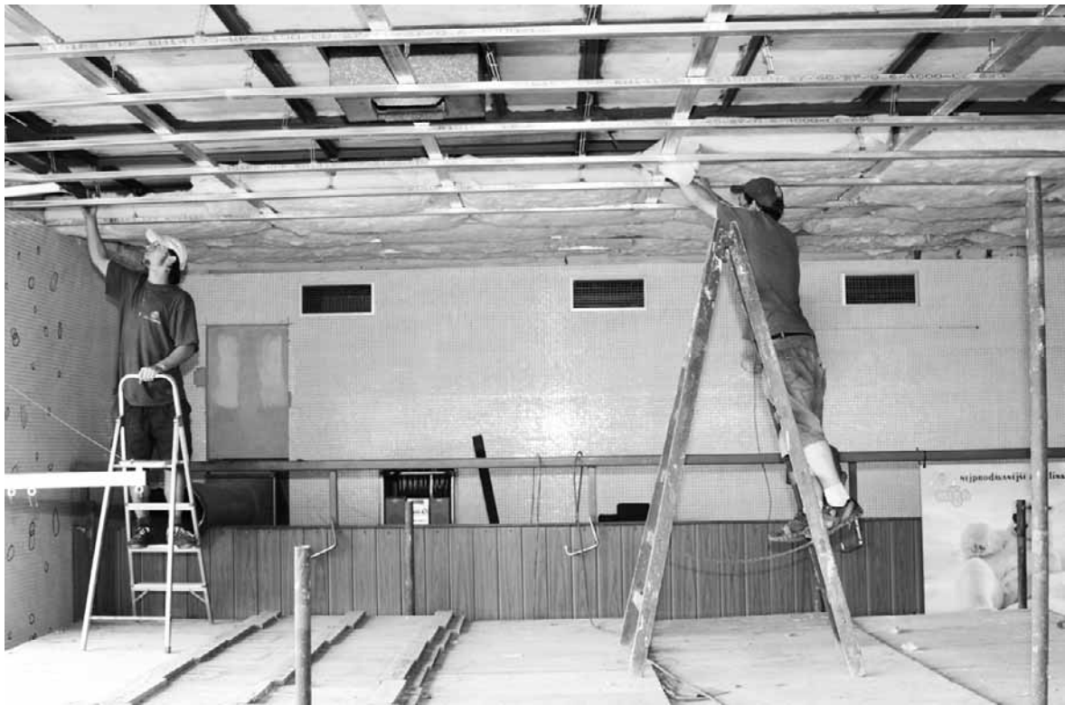
Řemeslníci provádějí demontáž stropu podhledu nad malým dětským bazénem a zateplení vrstvou kvalitní izolace. Foto: -kam-
