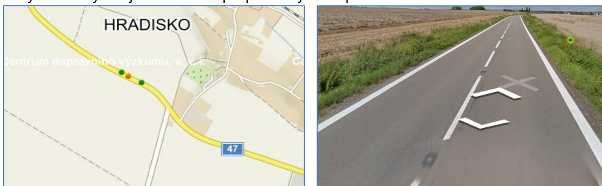
Obrázek 11 Silnice I/47 Postupky - Hradisko
