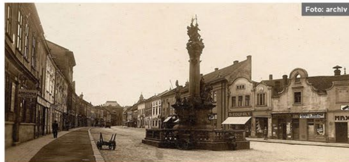
▲ Riegrovo náměstí, kde městská knihovna sídlila před II. světovou válkou. Dnes je v budově školní jídelna a některé radniční odbory.
