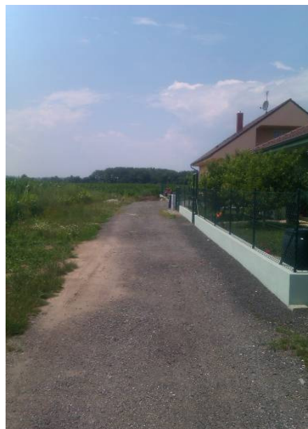
Komunikace podél jižních hranic řešeného území, pohled od východu
