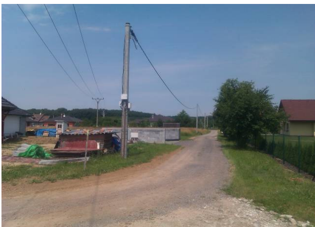
Komunikace podél východních hranic řešeného území, pohled od jihu,
