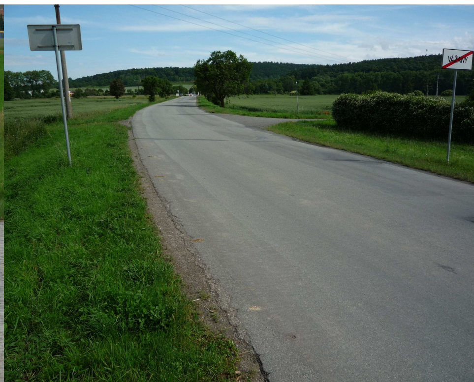
Pohled z Vážan směrem k železnicí, budoucí křižovatka trasy 1 s ulicí Lesní, vpravo živý plot areálu domova důchodců
