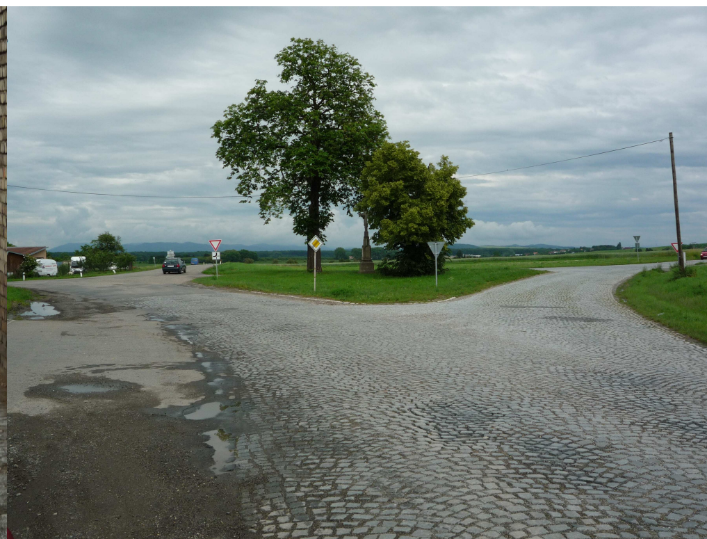
Křižovatka jižně Kotojed - trasa 4 (varianta 1 obchvatu), vlevo Kotojedy, vpravo silnice II/367 směrem na Trávník
