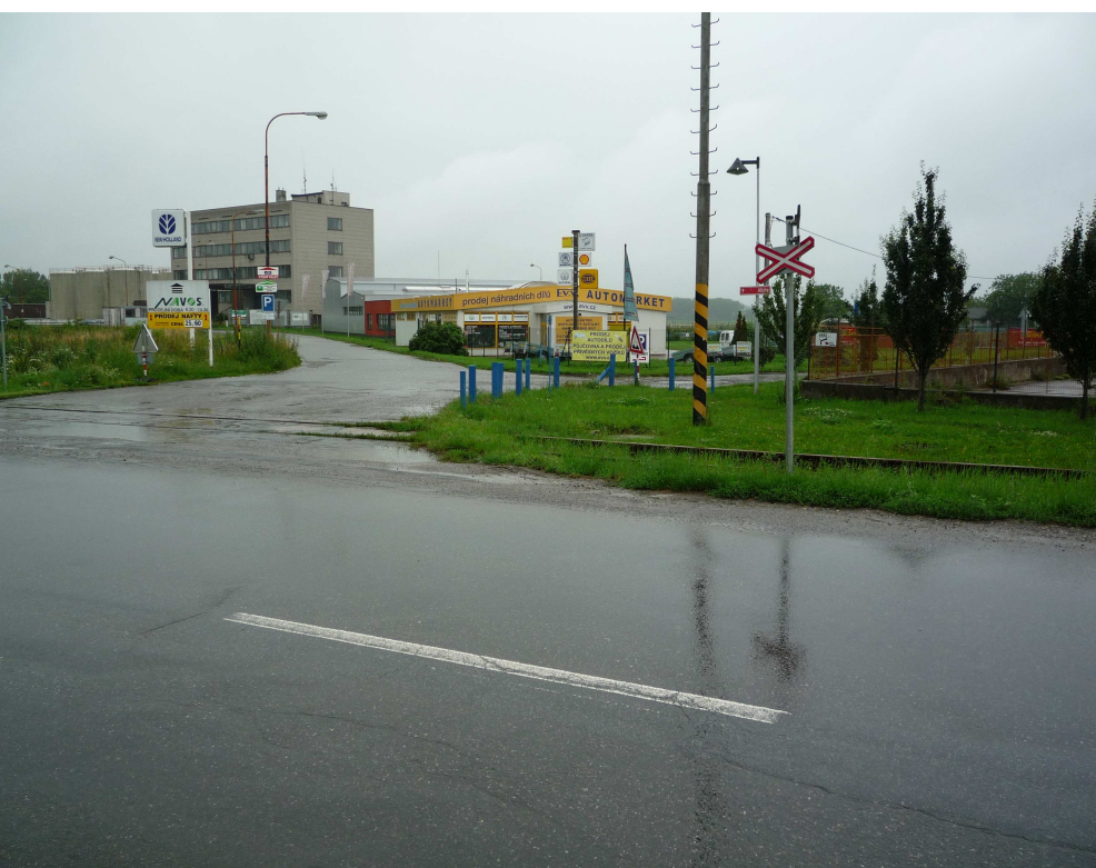
Vyústění ulice Altýře na Kotojedskou, železniční vlečka, budoucí estakáda varianty 2 (trasa 1)
