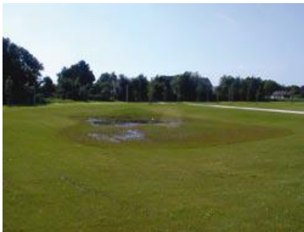
příklad vsakovacího pole
