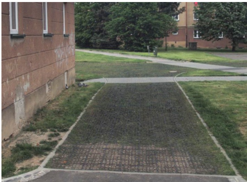
Obrázek 3 Příklad řešení parkování plastovými zatravněvacími rohožemi
