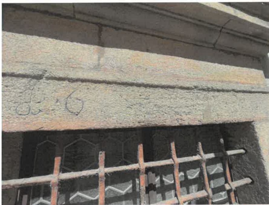
Detaily datace „1698“ na překladu nadsvětlíku portálu
