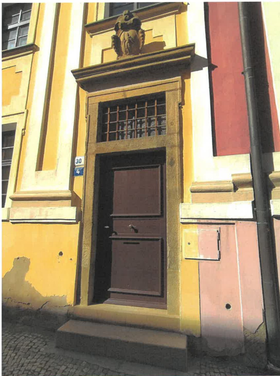
Pohled na vstupní portál z ulice Jánská
