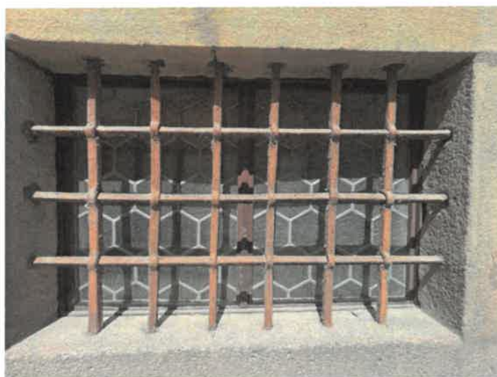
Detail kované mříže ve výplni nadsvětlíku – celoplošně dochován krakelovaný hnědý nátěr
