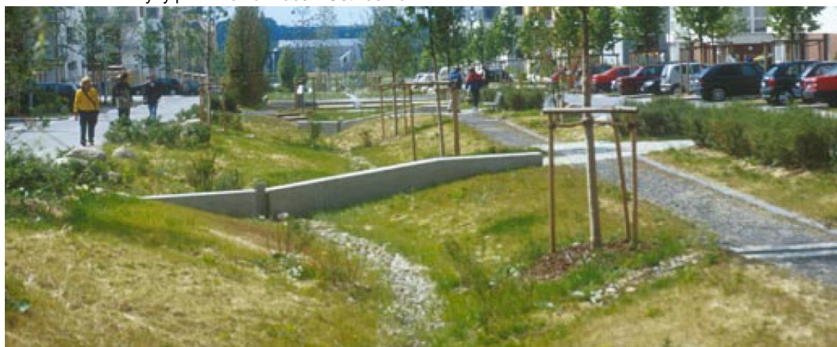
Příklad vsakovací rýhy podél komunikace v Ostfildernu
