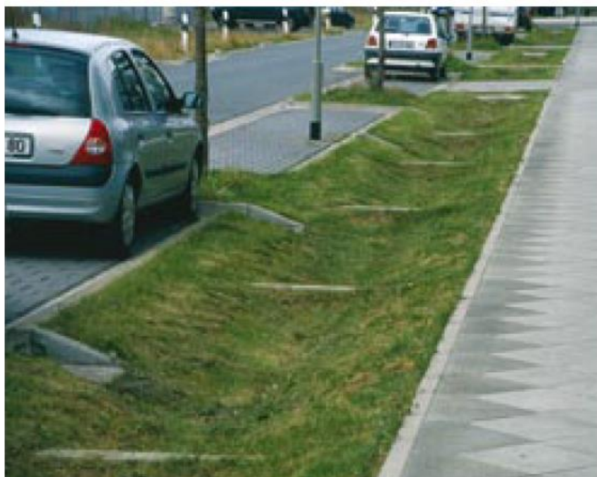
Příklad vsakovací rýhy podél komunikace v Ostfildernu
